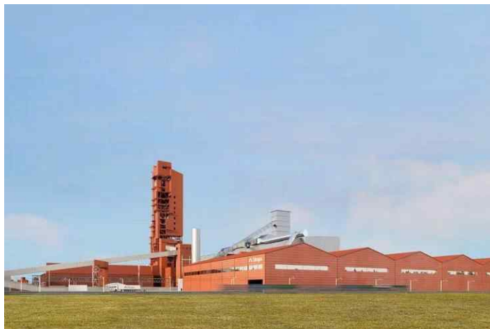
<사진: 건설 중인 Stegra의 740MW 보덴 제철소, 출처: Stegra>
